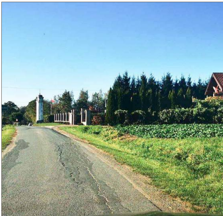
Stara Droga doczeka się w końcu gruntownej przebudowy.
