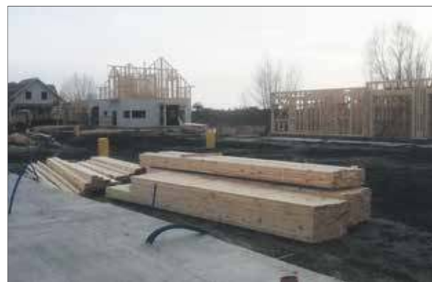
Domy szkieletowe wznoszone są w ekspresowym tempie, nawet w ciągu kilku dni
