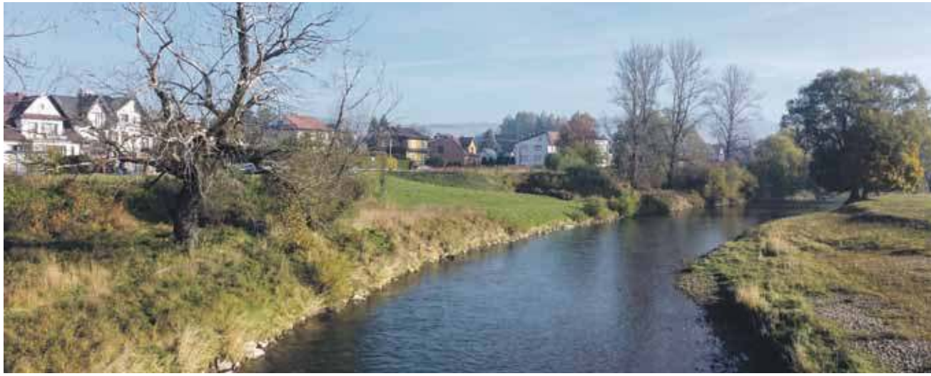
Mieszkańcy Grela i okolicznych ulic od lat apelują o budowę w tym miejscu kładki nad Czarnym Dunajcem.
