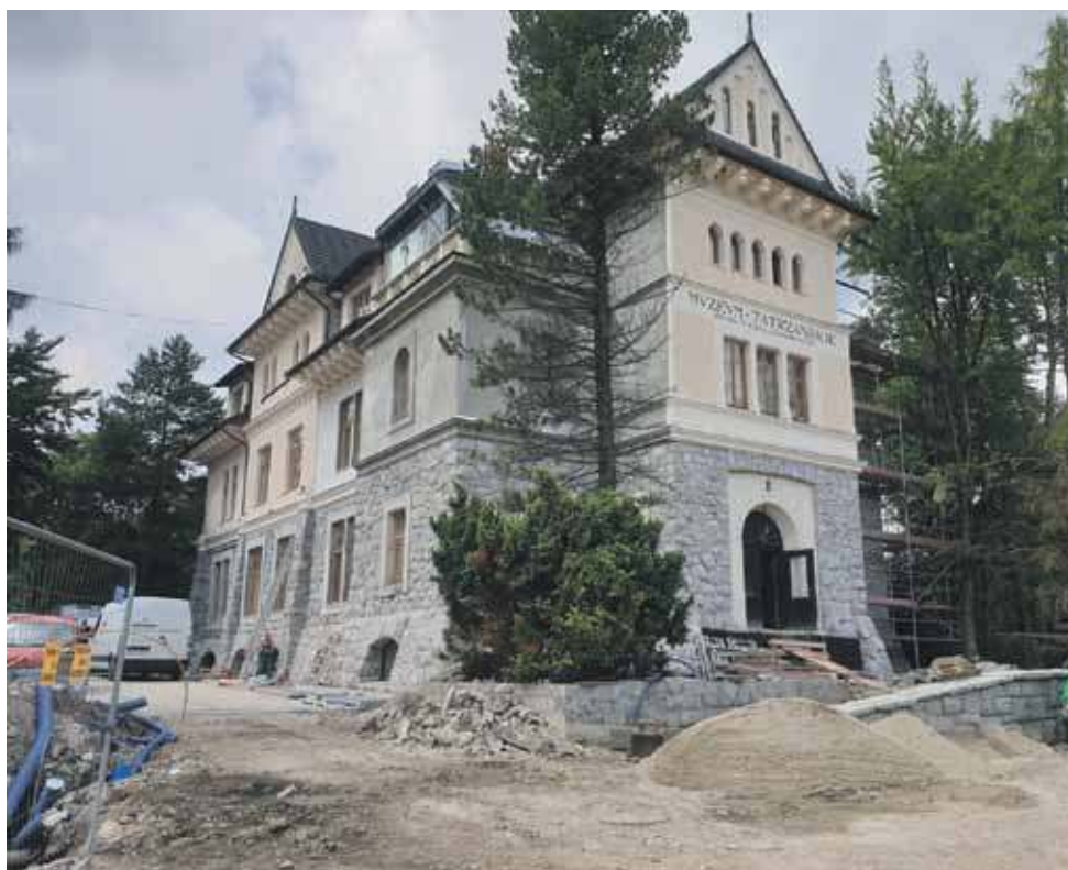
Gmach główny Muzeum Tatrzańskiego przechodzi gruntowny remont konserwatorski.
