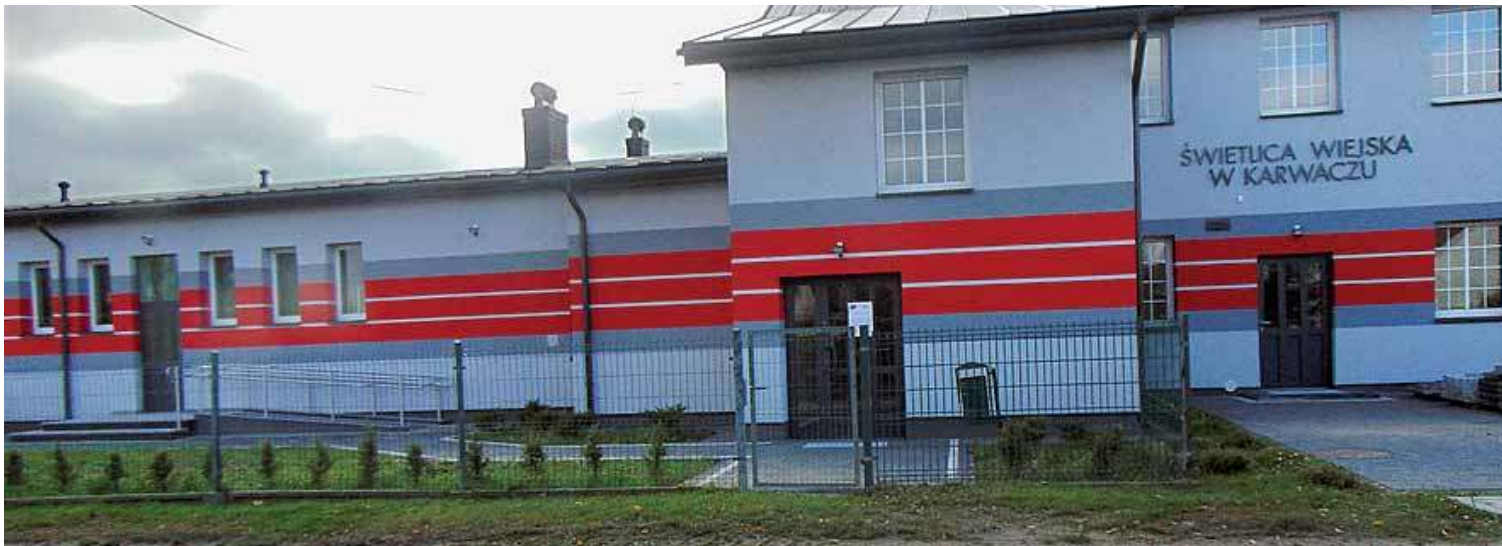
Przebudowa świetlicy gminnej w Karwaczu
