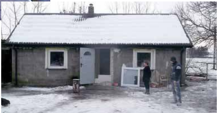
Ten dom po odbudowie
