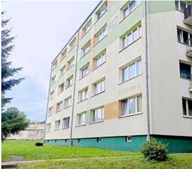
Spaleniu uległo jedno pomieszczenie w mieszkaniu w bloku przy ul. Kościuszki
