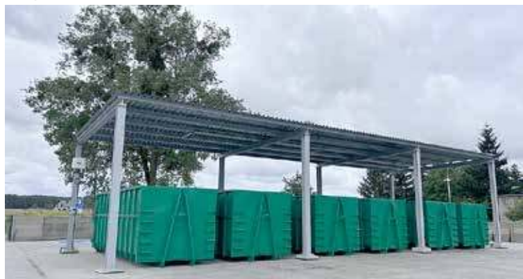
Teren obiektu to łącznie ponad 7 tys. m. kw. (fot. Gm. Przybiernów)
