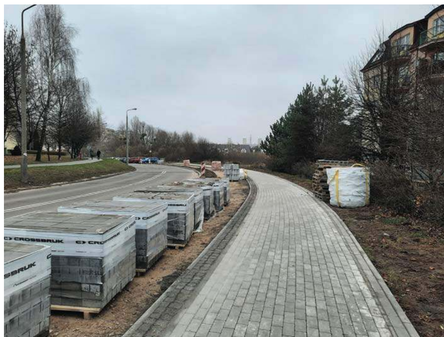
Prace budowlane na ul. Iwaszkiewicza
