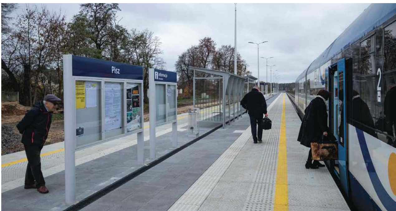
Zmodernizowana stacja Pisz
