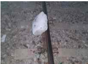
Ułożone na torowisku kamienie mogły doprowadzić do wykolejenia się pociągu
