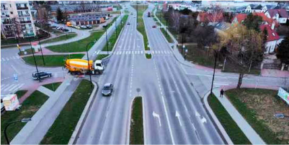
Skrzyżowanie przebudowanej ulicy Kusocińskiego z ul. Klonową i Czecha
