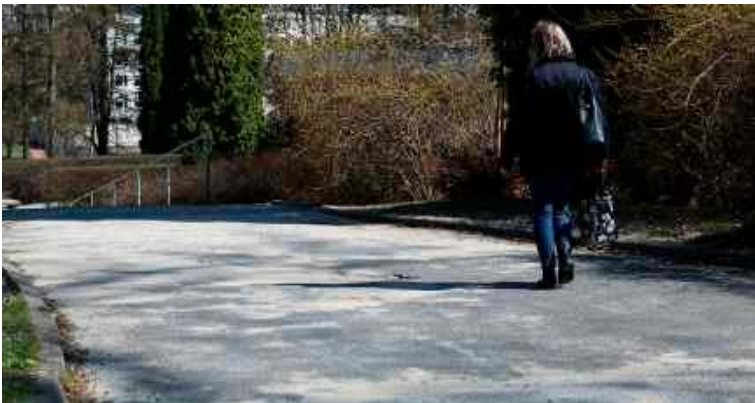
Najbardziej zniszczone fragmenty chodnika stanowiącego przedłużenie ulicy Bolesława Chrobrego zostaną wyremontowane
