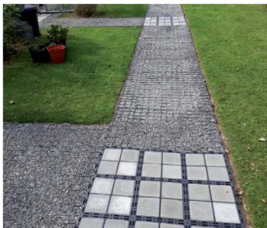
Ecoraster. Kratki parkingowe, które stabilizują grunt, odprowadzają wodę i świetnie wyglądają. Doskonale do podjazdów, parkingów i terenów zielonych. Przedstawiamy również system EcoBlox - kratka z kostką brukową, funkcjonalna nawierzchnia przepuszczalna, łącząca wygodę ekologicznej kratki z eleganckim wyglądem klasycznej kostki brukowej.
