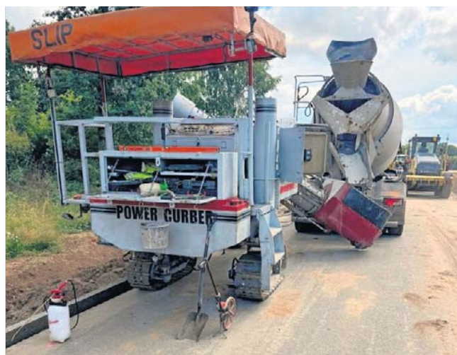
Przy budowie drogi Redzikowo-Jezierzyce wykorzystywana jest nowa technologia
