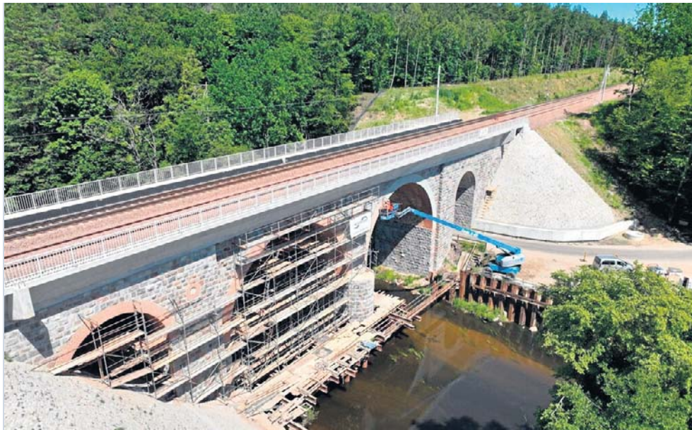
Remontowany most kolejowy nad rzeką Łupawą w Łebieniu
