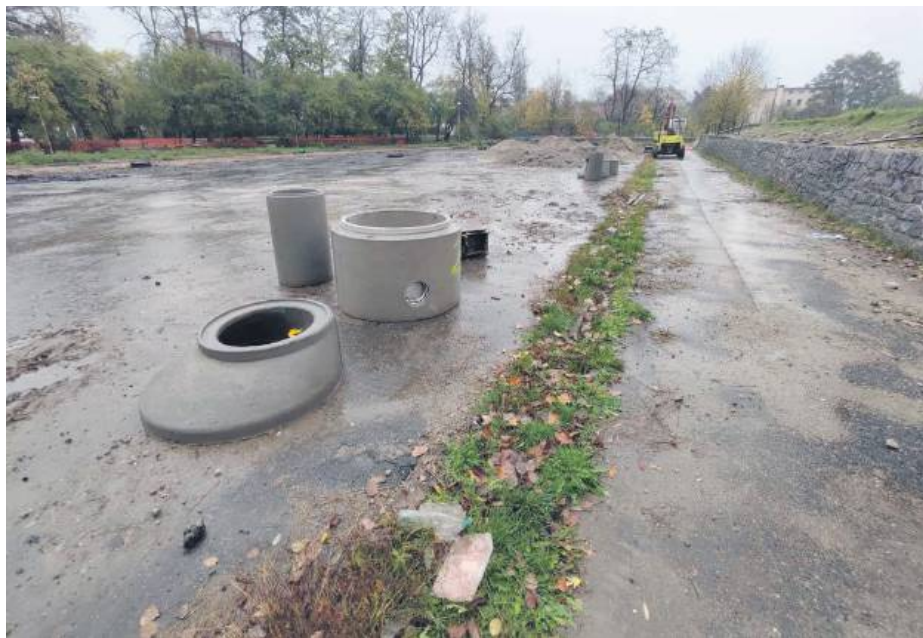
Kilka dni temu wznowiono prace związane z zagospodarowaniem terenu byłego lodowiska w Strzelinie. Obecnie wykonywany jest system odwodnienia
