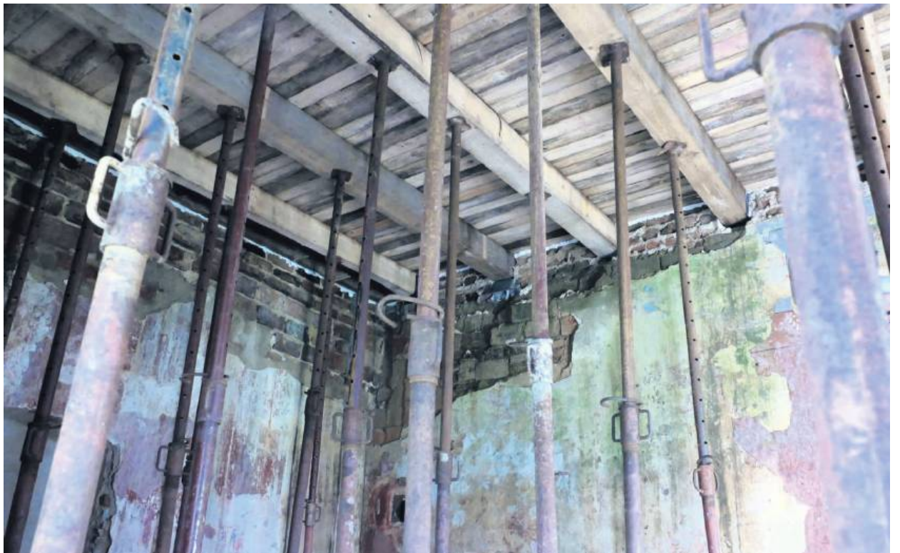
W tylnym traktcie budynku wykonano stropy żelbetowe
