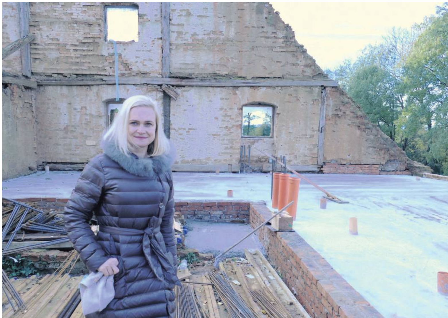
Emilia Skarzyńska, właścicielka dworu w Miechowicach Oławskich, na pierwszym piętrze budynku. W tle widoczne świeżo wylane stropy
