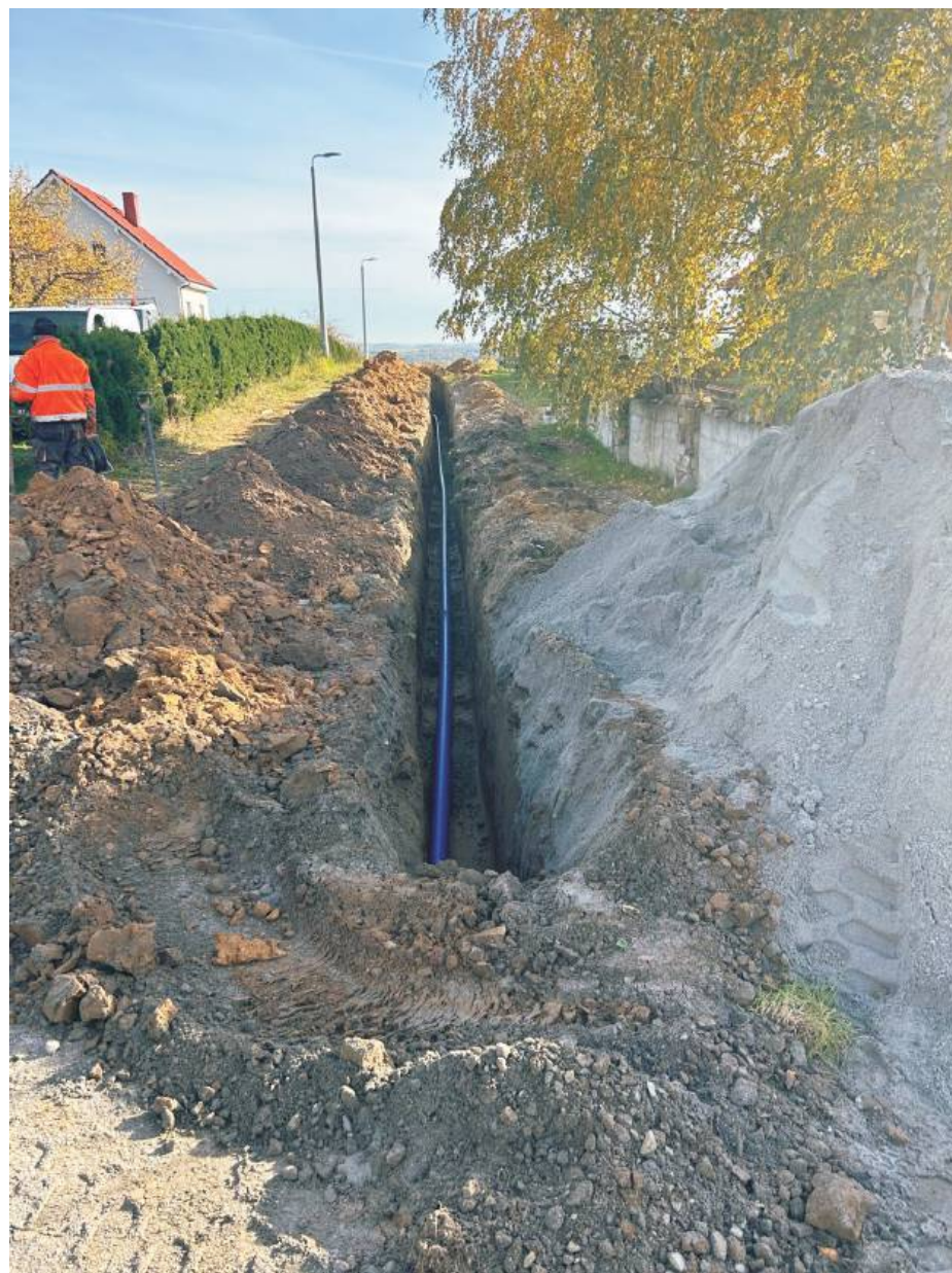
Za budowę wodociągu w Miłoticach odpowiada lokalna firma, Przedsiębiorstwo Handlowo-Usługowe Waldemar Ginter z Przeworna. Fot. UG Przeworno
