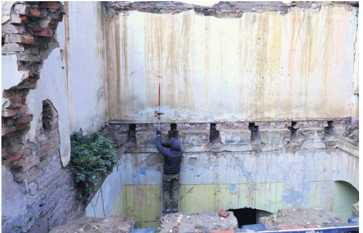
Prace na budowie w dworze w Miechowicach Oławskich idą pełną parą
