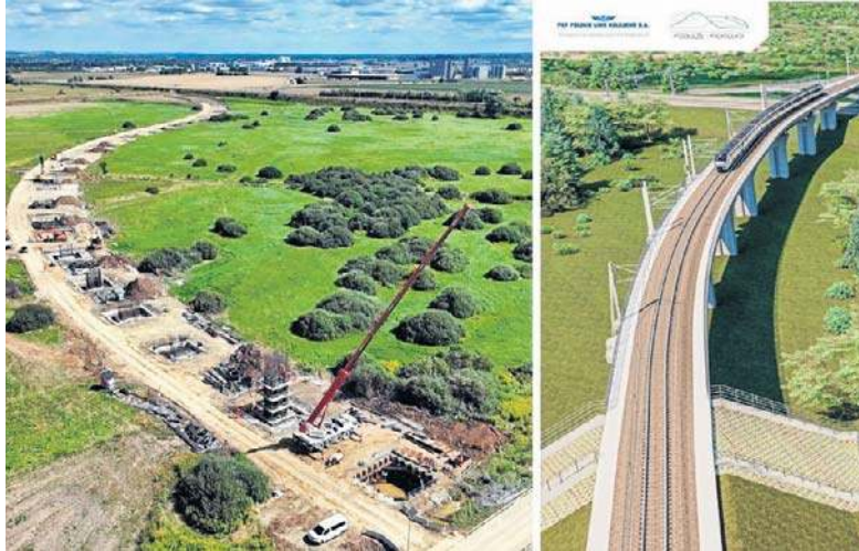
Tak powstaje nowa estakada kolejowa pod Krakowem
