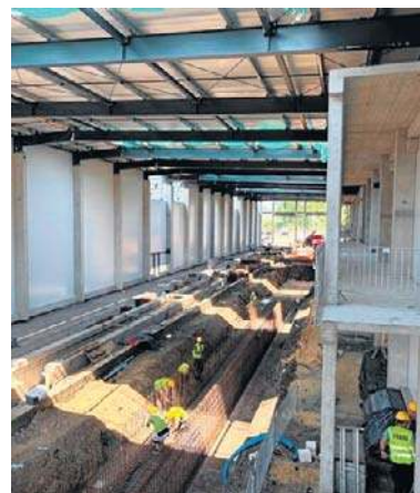
Budowa centrum serwisowego, postępuje bardzo szybko
