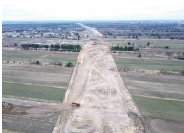
Budowa S19 Lubartów - Lublin. Marzec 2025 r.
