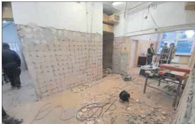
Remont budynku przy ulicy Towarowej 61 (fot. UM Jaworzno)
