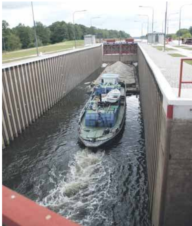
Śluzowanie barki w Rudzińcu. Różnica poziomów wody wynosi 6,25 m
