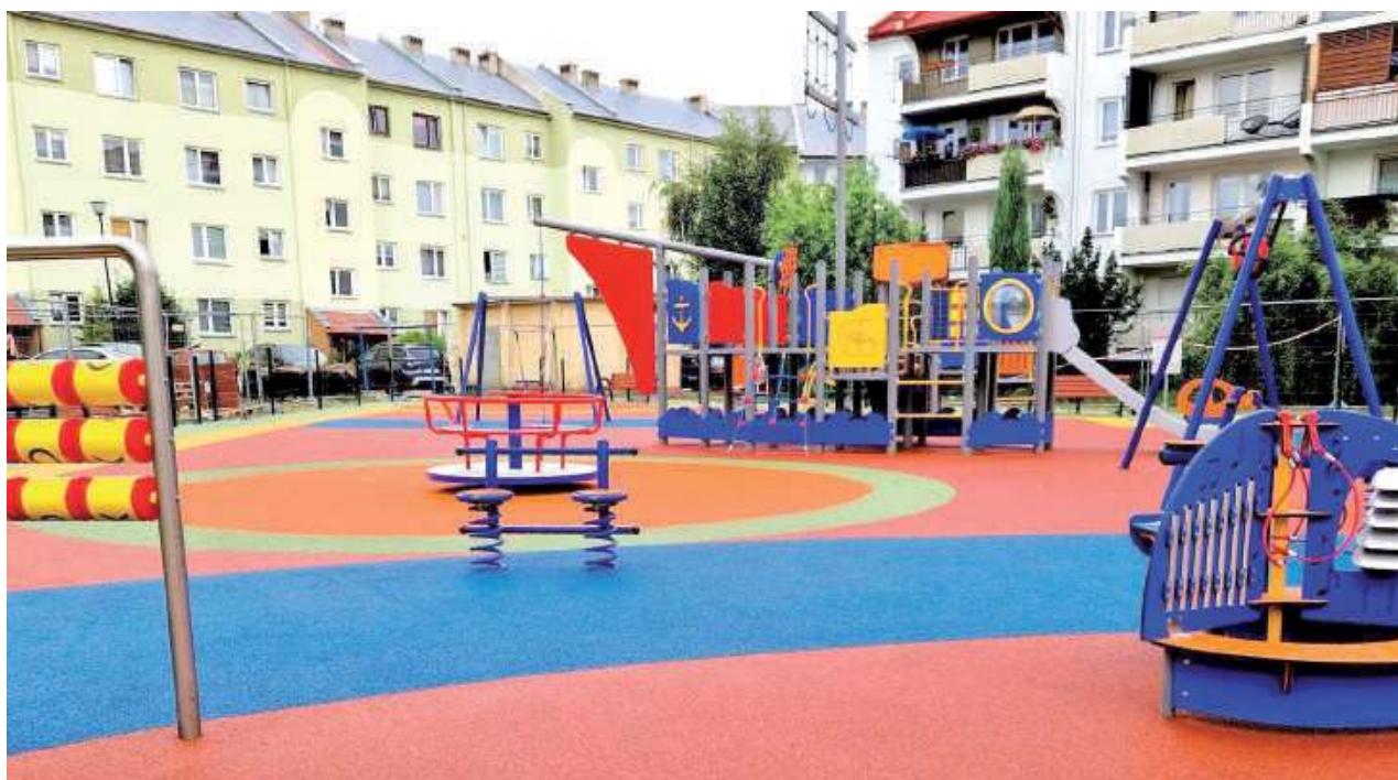
Prace na placu zabaw na os. Polna dobiegają końca. Modernizacja objęła m.in.: wykonanie nawierzchni z poliuretanu – (588 m 2 ); wymianę ogrodzenia panelowego z dwiema furtkami wejściowymi wraz z wymianą urządzeń zabawowych
