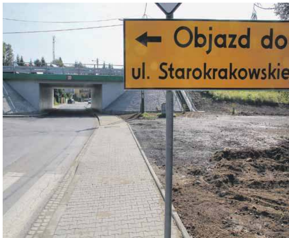
Remont wiaduktu zakończony, przejazd możliwy. Trwają wciąż prace przy budowie drogi Grel - Niwa, stąd objazd do Starokrakowskiej.
