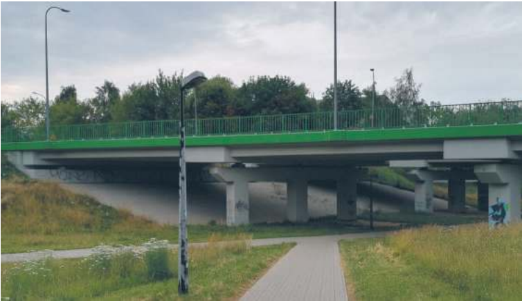
Stare latarnie w wąwozie zostaną odmalowane, a oprawy oświetleniowe zamienione na ledowe
