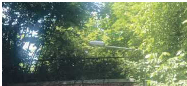
Byłe torowisko na wiadukcie porasta bujna roślinność
