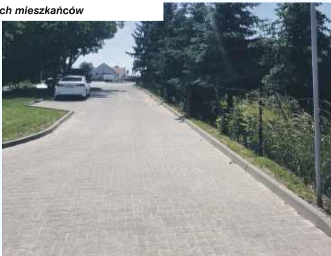
Nowa droga dojazdowa do przedszkola w Krynicznie
