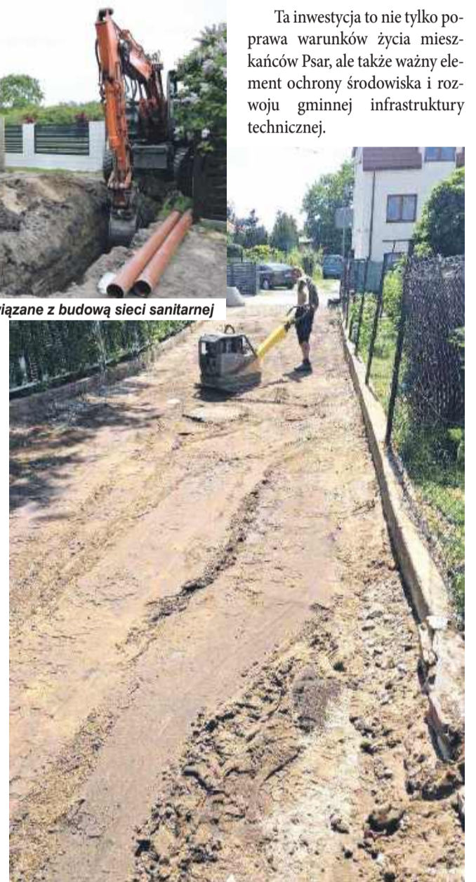
Odtworzenie nawierzchni drogowej po zakończeniu robót
