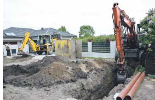
Tak wyglądały prace budowlane związane z budową sieci kanalizacji sanitarnej
