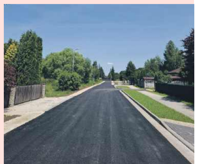
Nowa nawierzchnia ul. Kwiatowej w Szewcach
