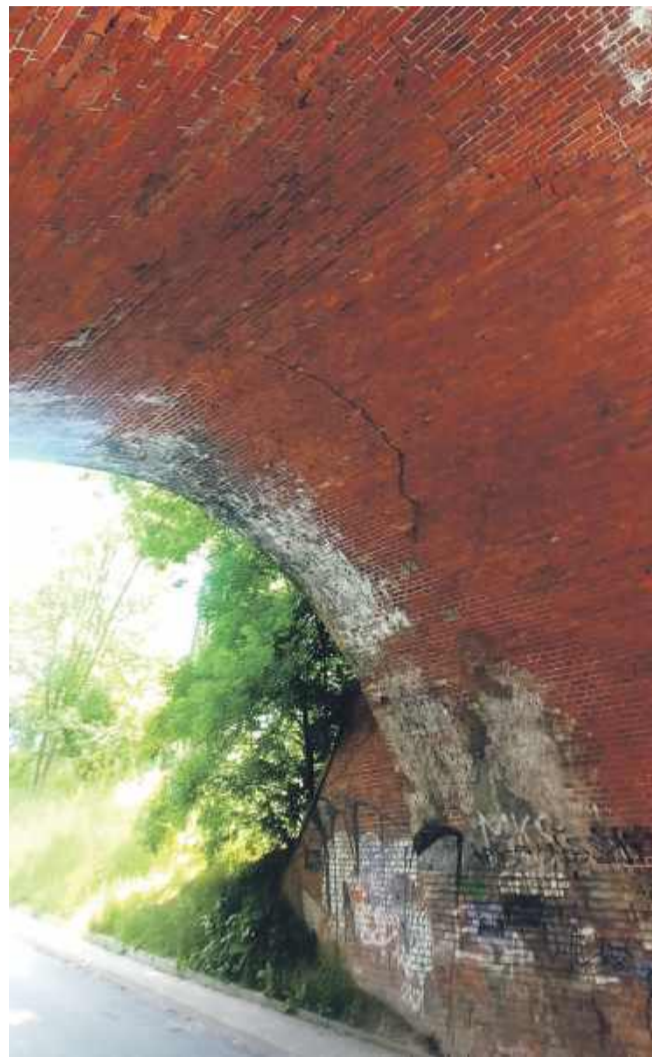
Widać pęknięcia i kruszące się cegły
