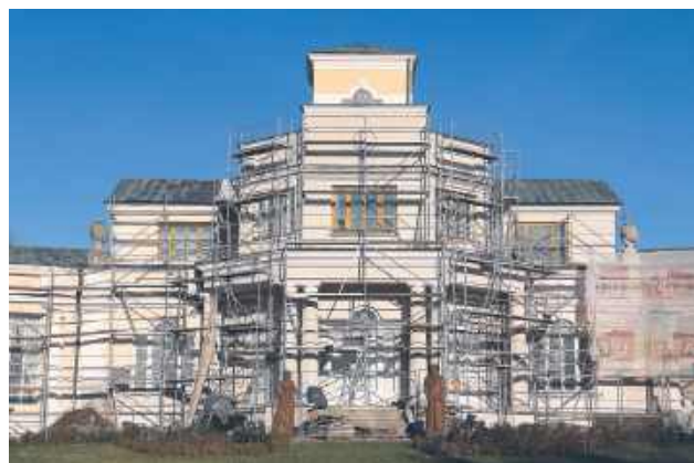
Koszt remontu elewacji siedziby Urzędu Gminy to prawie 3 mln zł
