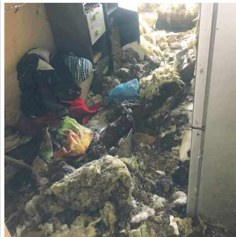
Tak po pożarze wygląda wnętrze domu w Andrzejowie. Trwa zbiórka na remont
