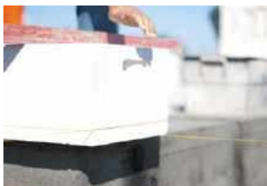
❹ Z betonu komórkowego buduje się szybko, bo bloczki są duże, ale jednocześnie lekkie. Murowanie ułatwiają też wyfrezowane uchwyty montażowe. TERMALICA (BRUK-BET), YTONG (XELLA)
