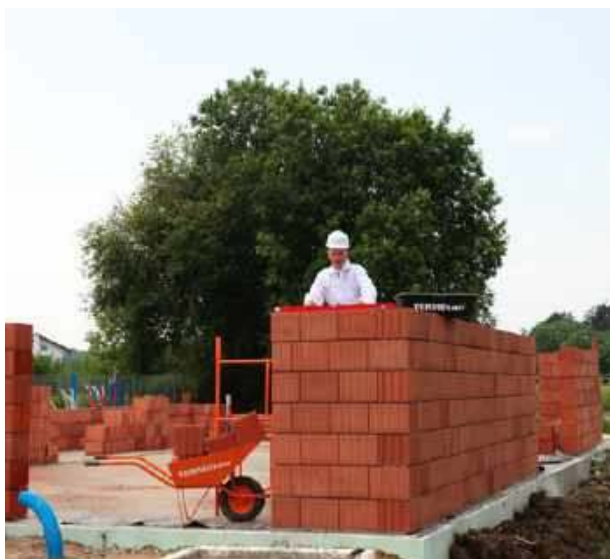
❸ Ceramika tradycyjna jest chętnie wybierana do budowy ścian warstwowych, ale na przegrody bez ocieplenia się nie nadaje – ma zbyt słabe parametry cieplne. ZCB OWCZARY
