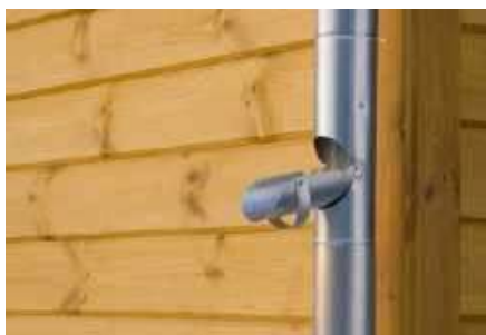
❺ Przymocowanie rury spustowej w obejmach.
