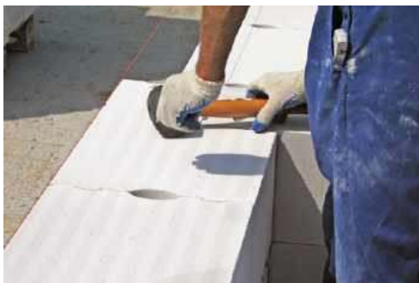
❷ Beton komórkowy ma w środku mikropory z powietrzem, które pełni rolę izolatora cieplnego. Dzięki temu wykonane z niego ściany mają bardzo dobre parametry termiczne. SOLBET
