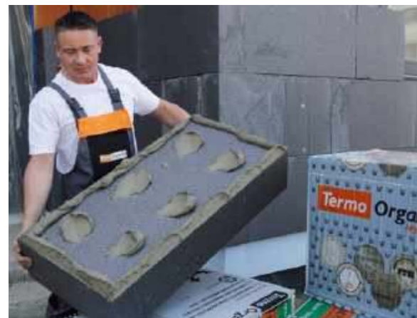
❗ W metodzie lekkiej mokrej zaprawę klejową nanosi się na płyty metodą obwodowo-punktową. TERMO ORGANIKA
