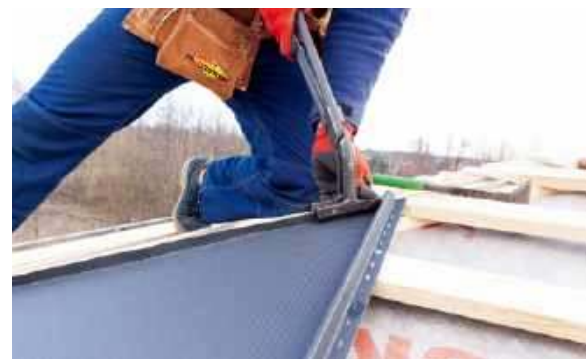
Układanie paneli na połaci dachu. BLACHY PRUSZYŃSKI
