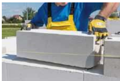
❹ Z betonu komórkowego buduje się szybko, bo bloczki są duże, ale jednocześnie lekkie. Murowanie ułatwiają też wyfrezowane uchwyty montażowe. TERMALICA (BRUK-BET), YTONG (XELLA)
