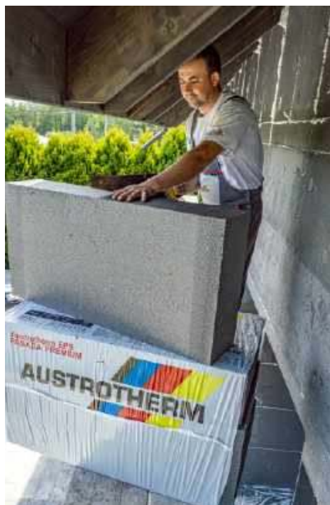
🔗 Ściany najczęściej ociepla się styropianem. AUSTROTHERM
