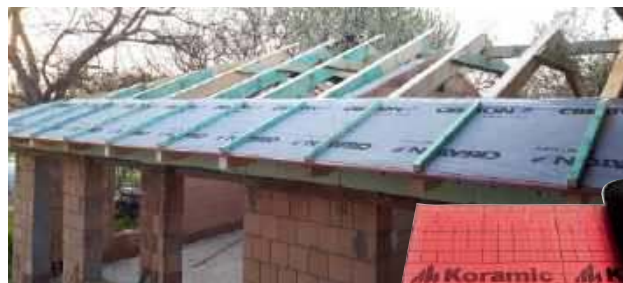
➤ Membrany zabezpieczają termoizolację przed wilgocią od zewnątrz. CREATON POLSKA, WIENERBERGER
