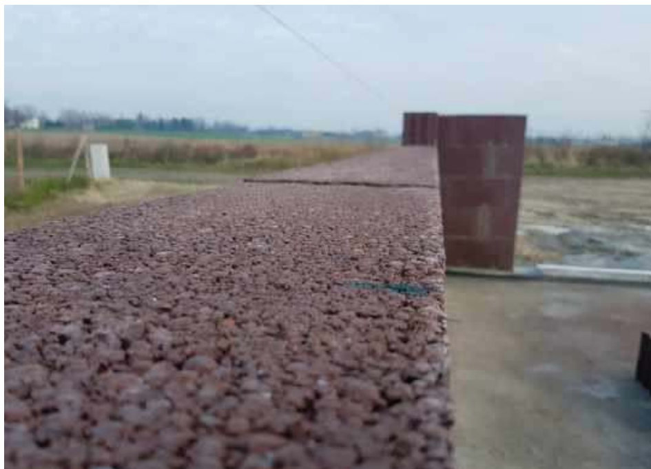
U Keramzytobeton to budulec porowaty i lekki, a jednocześnie wytrzymały. Wykonuje się z niego ściany dwuwarstwowe. CZAMANINEK
