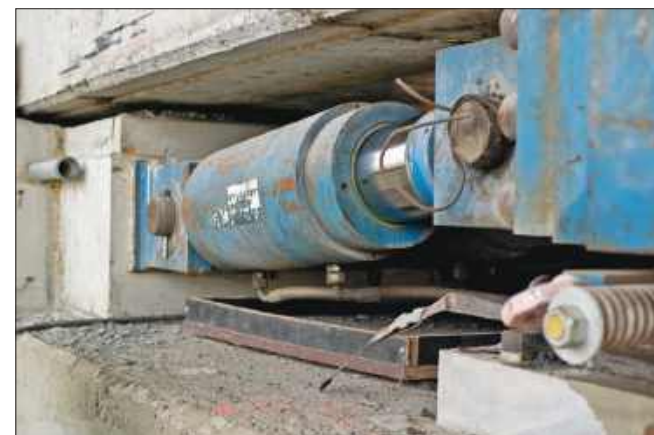
■ Pod mostem, przy użyciu tych urządzeń, przesuwało konstrukcję na miejsce docelowe.
