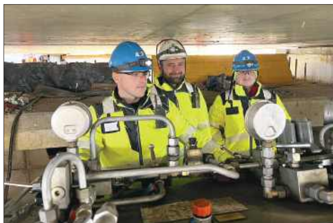
■ Pod mostem, przy użyciu tych urządzeń, przesuwało konstrukcję na miejsce docelowe.
