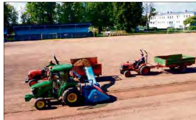
Murawa na stadionie Unii Krapkowice przechodzi gruntowny remont.
