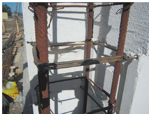
RYS. 20–22 Przykłady sposobów połączenia żelbetu i muru: przez strzepy (20), przez zbrojenie (21) oraz przez zbrojenie spoin wspornych (22)
