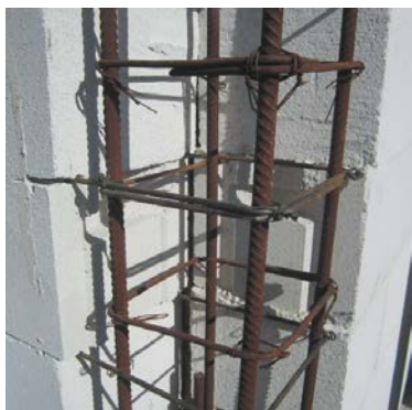
FOT. 5–6 Połączenie rdzenia i muru: przez zbrojenie wypuszczone ze spoin; fot.: Łukasz Drobiec
