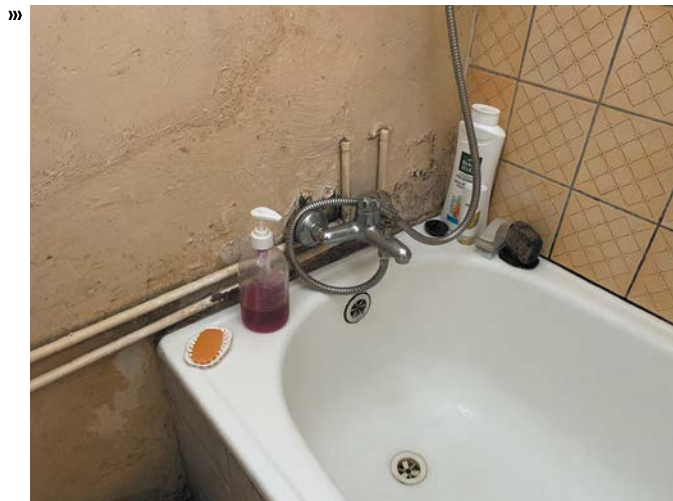
FOT. 2 Rozwój grzybów pleśniowych w pomieszczeniach kojarzonych z utrzymaniem higieny powinien niepokoić, choć z drugiej strony sama jego obecność nie oznacza jeszcze zagrożenia dla zdrowia; fot.: autor
