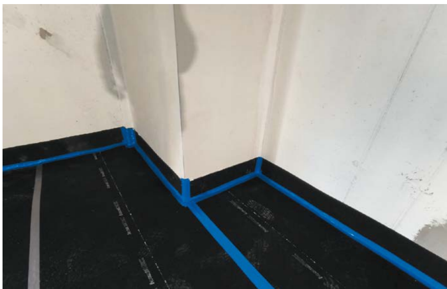
Mata na duże obciążenia + poprawnie wykonana dylatacja – mata EPUACOUSTICS na duże obciążenia; fot.: Epufloor
