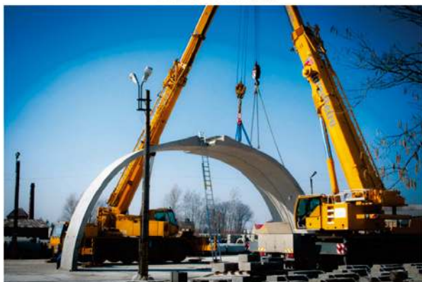
ZAKŁAD BETONÓW W KOLBUSZOWEJ - MONTAŻ ELEMENTÓW ŁUKOWYCH
