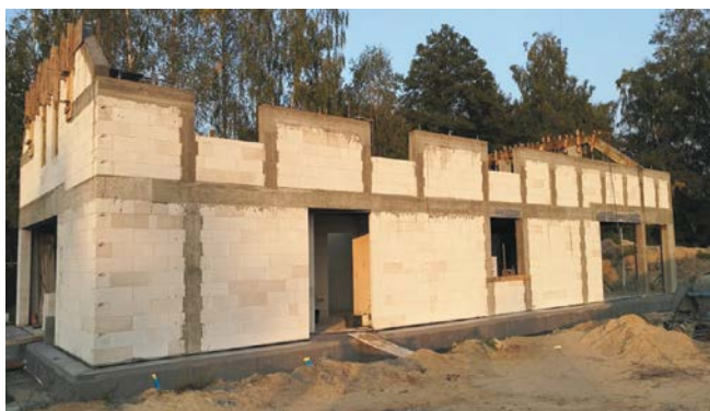
FOT. 3 Przykład murów skrępowanych w budynku mieszkalnym jednorodzinnym; fot.: autor
