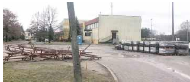
Przy „Piątce”, gdzie znajduje się lodowisko, jest teraz plac budowy
