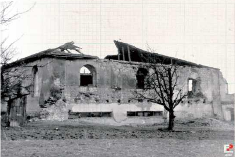
Zniszczony budynek synagogi w Józefowie
