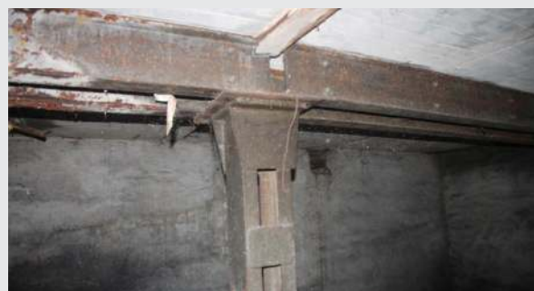
Fot. 6 Stalowa konstrukcja podpierająca strop żelbetowy obiektu schronowego z lat 70. XX w.
