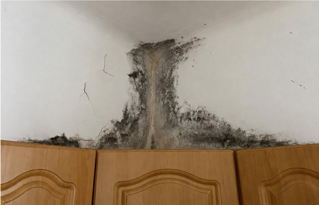
Fot. 1 Intensywne porażenie pleśnią w narożniku pomieszczenia
