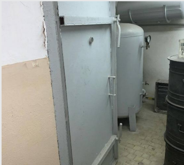
Fot. 3 Przykład istniejących stalowych drzwi ochronnych
