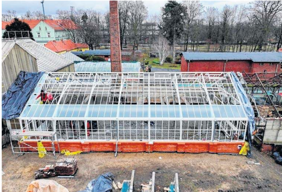
Szkło już dojechało i jest układane na dachu obiektów Palmiarni
