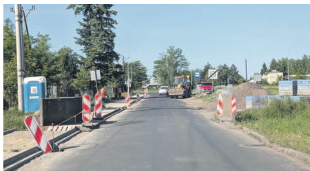
Trwa remont tego odcinka ul. Zielnej
