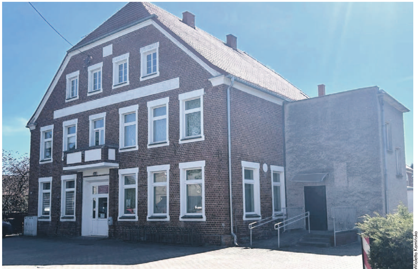
Budynek świetlicy w Wójcicach - 2026 r.
