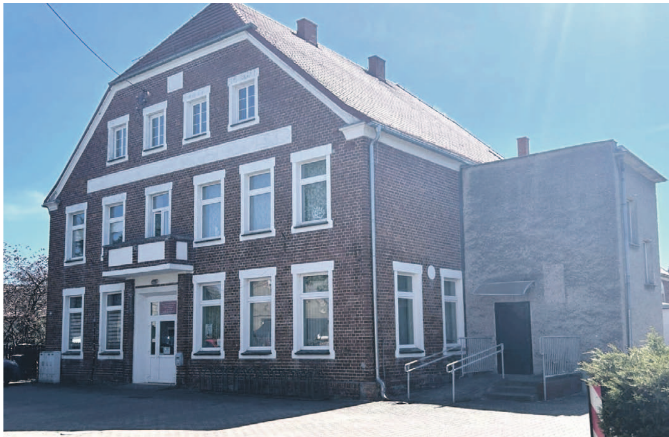
Budynek świetlicy w Wójcicach - 2026 r.
