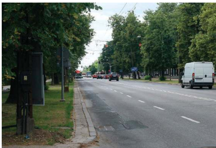
Przebudowa ma udrożnić jedną z głównych arterii komunikacyjnych Lublina. Niestety odbędzie się to kosztem wycinki ponad 100 drzew
