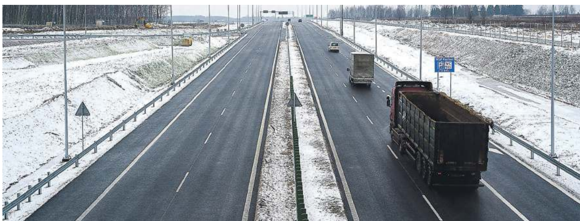
Odcinek drogi ekspresowej S19 Łowisko – Sokołów Małopolski ma długość około 8,2 kilometra. Wartość kontraktu wynosiła 286 403 716,49 zł
