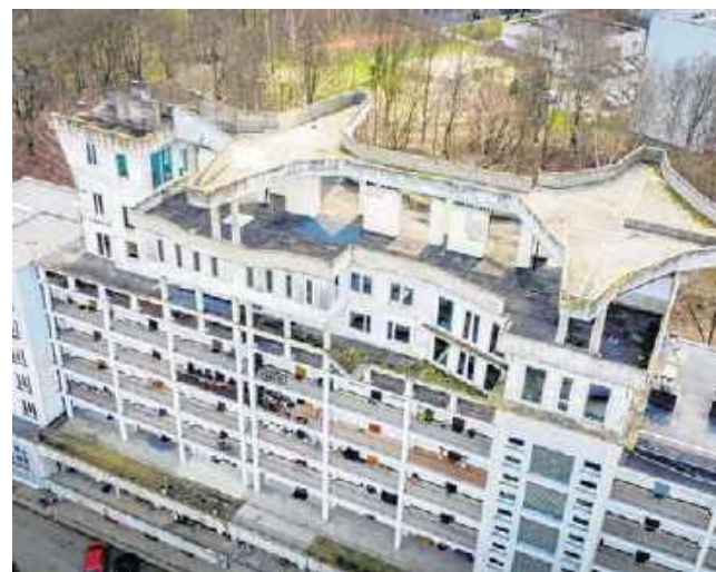
Część nadbudowy została już rozebrana
