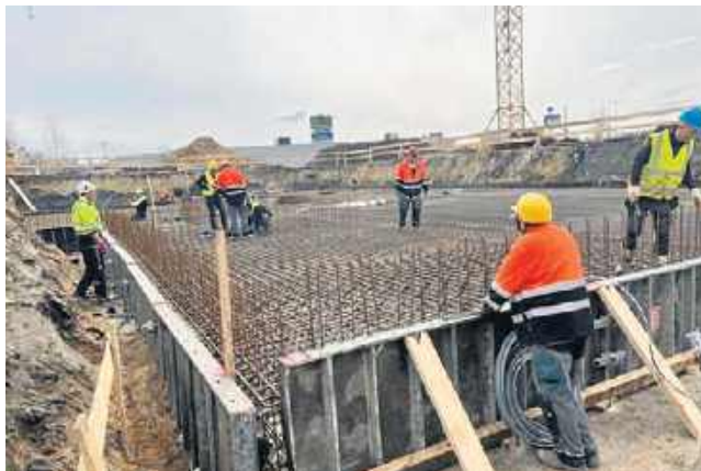
Budowlańcy uwijają się od rana do wieczora. Pierwsze efekty prac już widać
