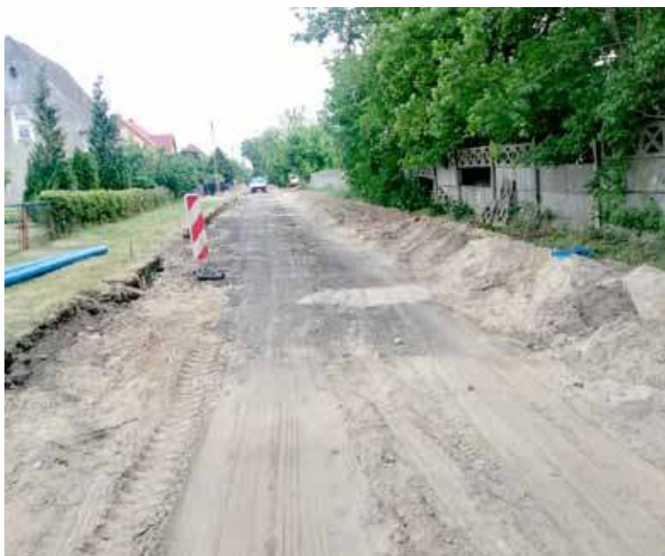
W ramach prac zostanie przebudowane 311 mb drogi oraz kanalizacja deszczowa, powstanie też chodnik oraz zjazdy do posesji
