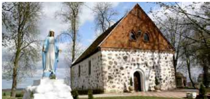
Na zdjęciu kościół w Starej Dąbrowie, gdzie niedługo ruszy remont dachu
