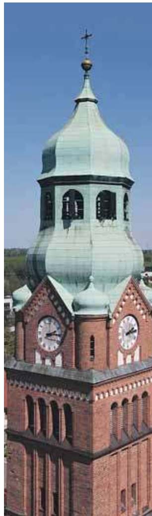
W latach 90. podczas burzy został uszkodzony hełm wieży i w trakcie naprawy wyjęto z gałki dokument spisany przez budowniczych w 1911 r.
