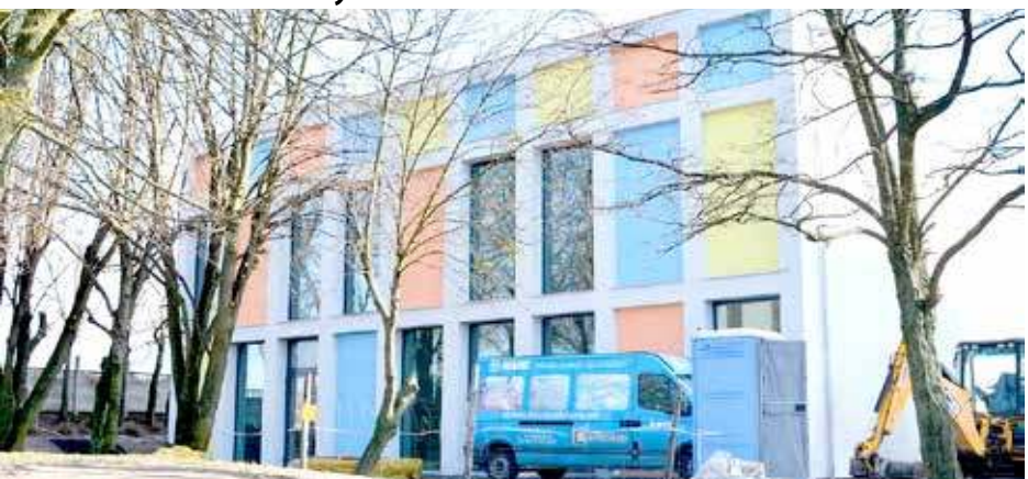
Sala gimnastyczna SP Głuszyno
