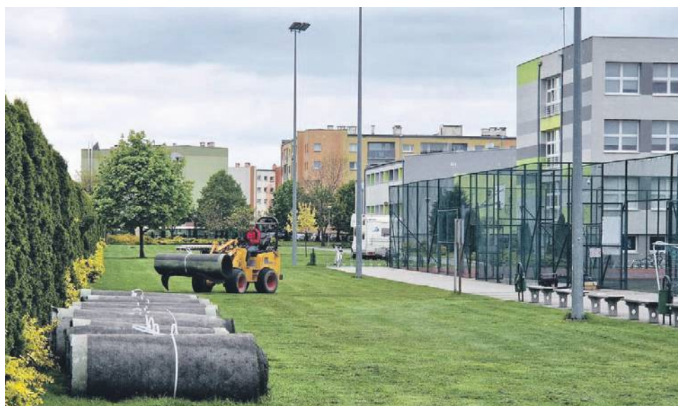
Przy Szkole Podstawowej nr 8 rozpoczął się remont Orlika, usuwana jest stara nawierzchnia ze sztucznej trawy
