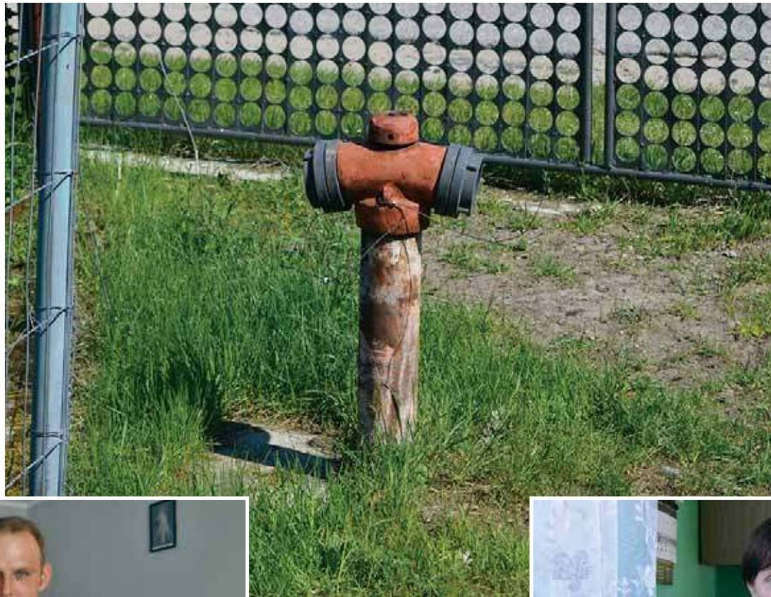
Hydrant na posesji państwa Domańskich, gdzie znajduje się zasuwa do przyłącza państwa Borowskich stał się powodem afery wodociągowej
