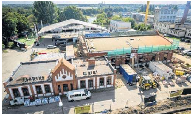
Trwa odbudowa spalonej Fabryki Lloyd
