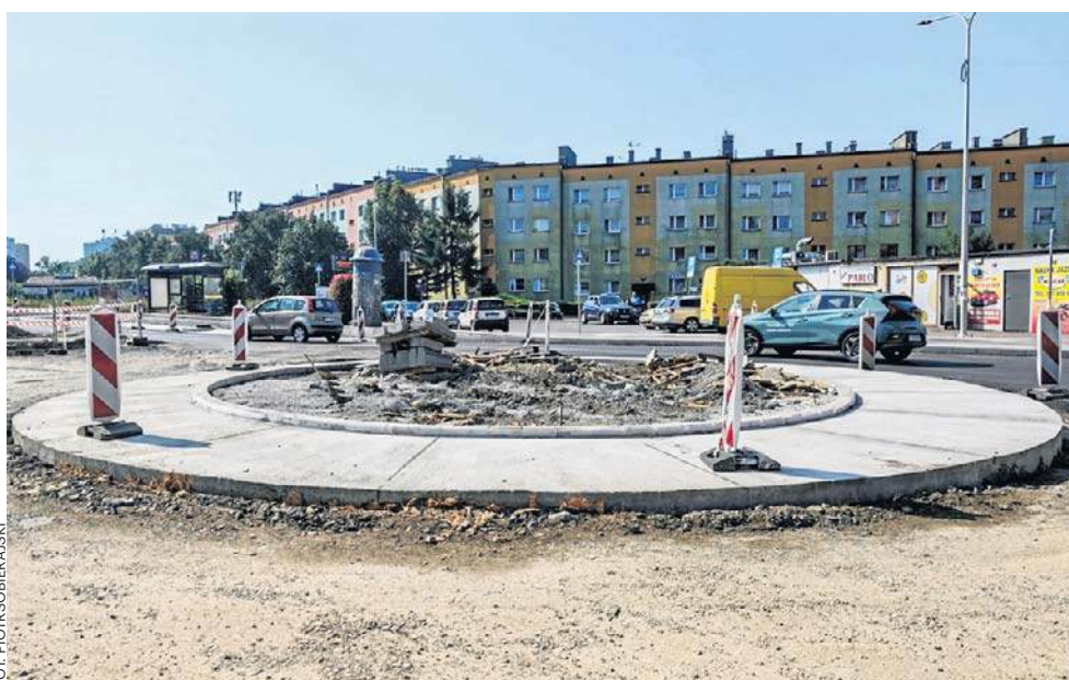
W Czeladzi trwa remont nawierzchni ul. Wojkowickiej (zdjęcie u góry), a w Dąbrowie Górniczej powstaje m.in. nowe rondo, które zastąpi skrzyżowanie w dzielnicy Gołonóg
