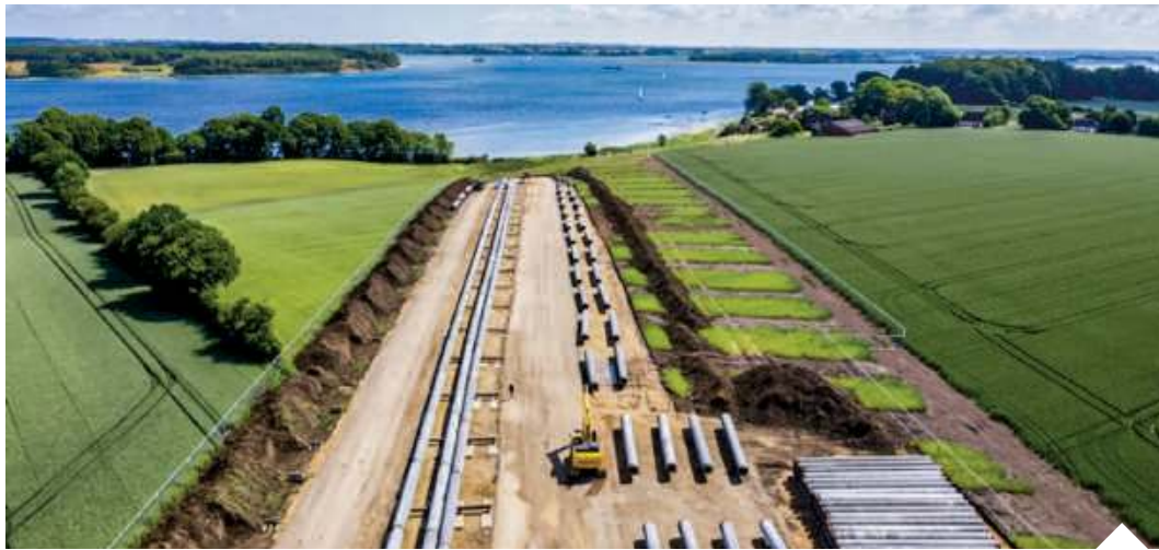
Rozpoczęto prace przy budowie podmorskiej części gazociągu Baltic Pipe | fot. Baltic-pipe.eu/d
