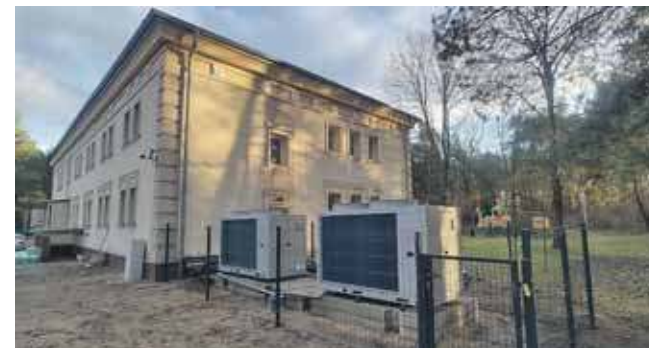
Montaż pomp ciepła i zapasowego źródła ogrzewania kosztował prawie pół miliona złotych
