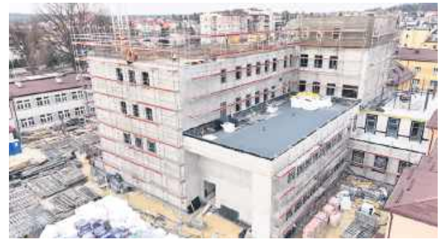
Budowa Centralnego Bloku Operacyjnego w Tomaszowie Lubelskim. Fot. SP ZOZ Tomaszów Lubelski
