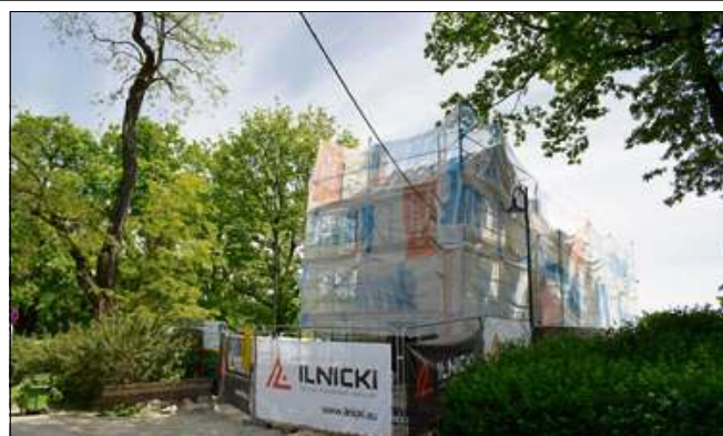
Prace remontowe idą pełną parą.
