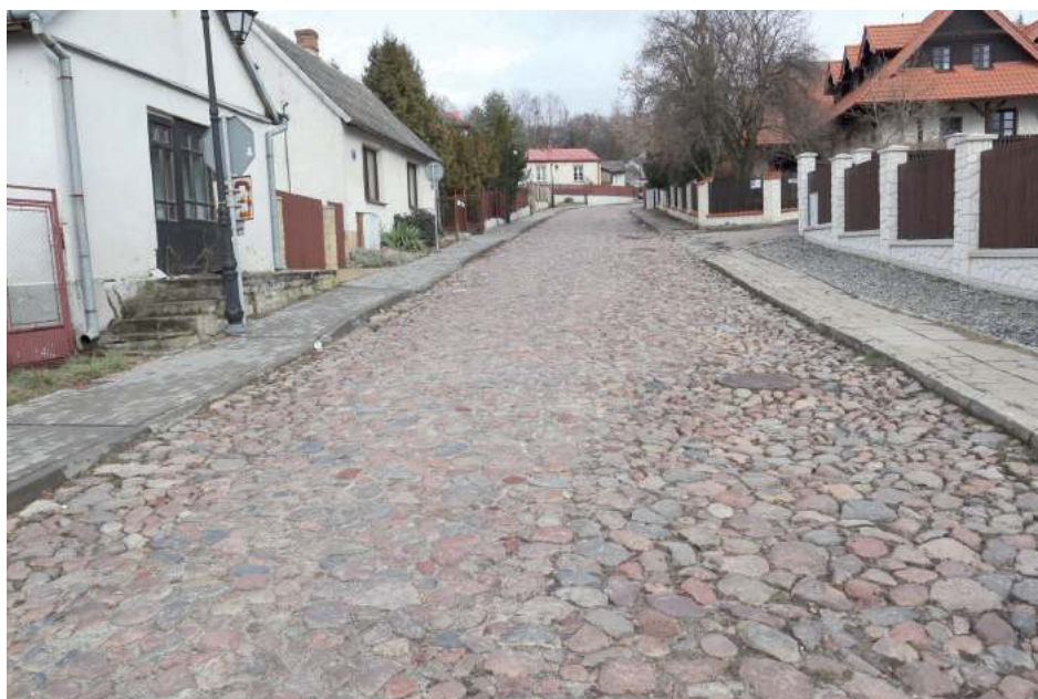
Zarówno Wojewódzki Konserwator Zabytków, jak i miejscowe władze podkreślają, że bruk na ul. Lubelskiej wpływa na unikatowość Janowca
