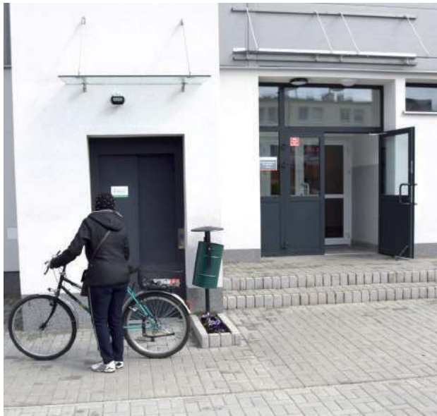
Wejście do budynku „Uskok”, obok winda, która przez wiele miesięcy nie działała
