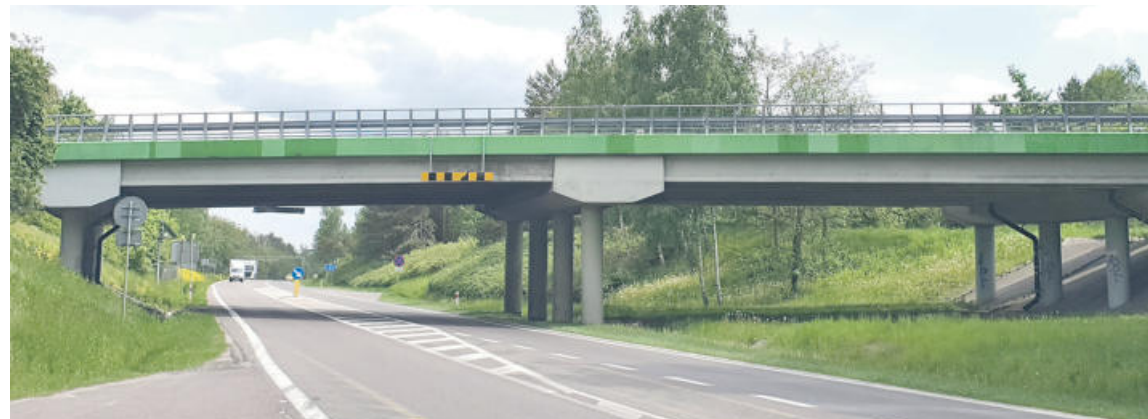
Wiadukt na ul. Domanickiej będzie zburzony.
