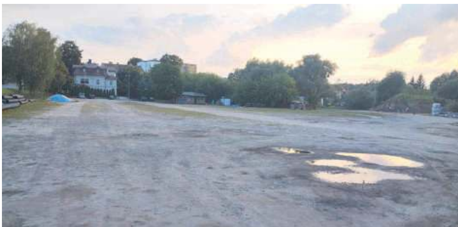
Tak obecnie wygląda plac targowy w Wąwolnicy. Sprzedający, jak i kupujący narzekają na nawierzchnię i dziury. Po obfitych opadach deszczu suchą stopą niestety ciężko przejść
