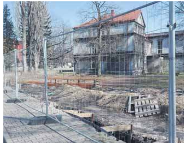
Ogrodzenie miało być gotowe miesiąc temu, a jest tylko rozkopany plac budowy
