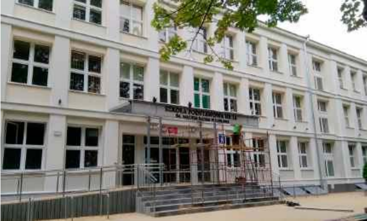
Nowa elewacja „Osiemnastki” cieszy oko
