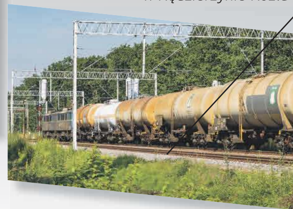
Zrewitalizowana linia kolejowa 872 w Kędzierzynie-Koźlu
