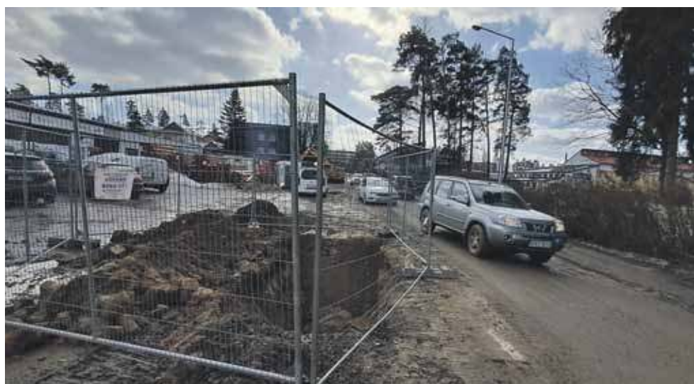
Pierwsze wykopy w powstającej Strefie Aktywności Gospodarczej.
