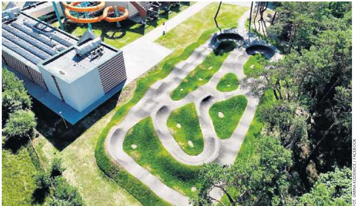
Obok krytej pływalni Delfin w Kozienicach powstał między innymi nowy pumptrack.
