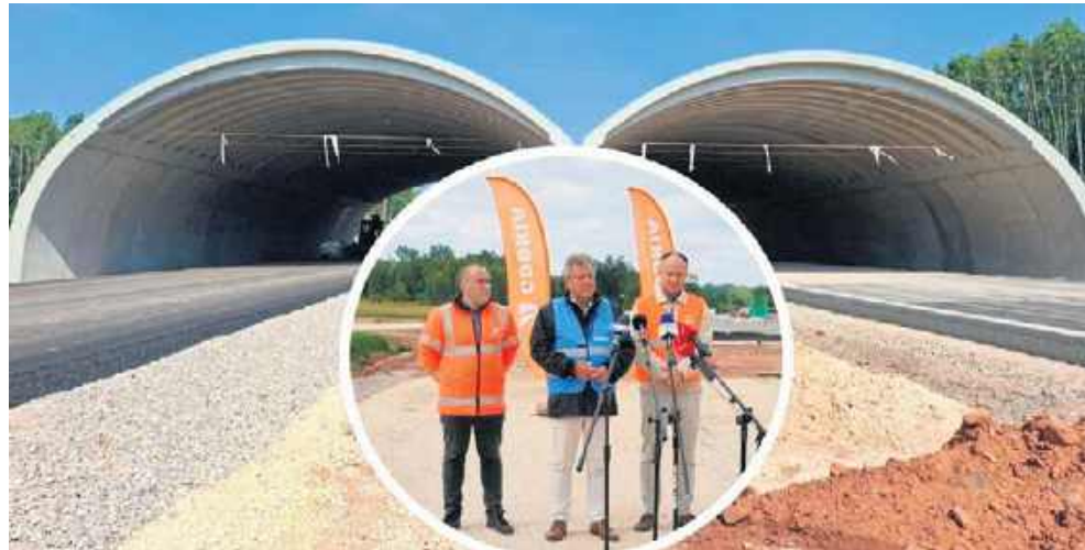
Mosty, wiadukty i asfalt. Tak wygląda półmetek budowy S74 od Mniowa do Kielc. Z postępami prac zapoznał się wojewoda świętokrzyski Józef Bryk
